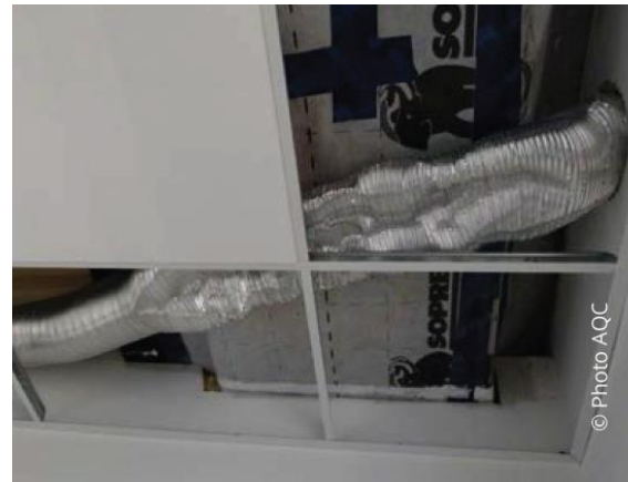
Mise en œuvre
