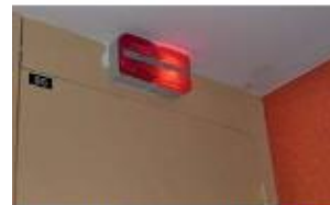
4. Voyant d'alarme de dysfonctionnement.
