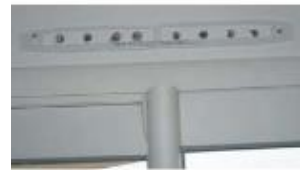
2. Entrées d'air non calibrées.
