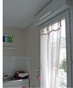
1. Entrées d'air dans une pièce de service.
