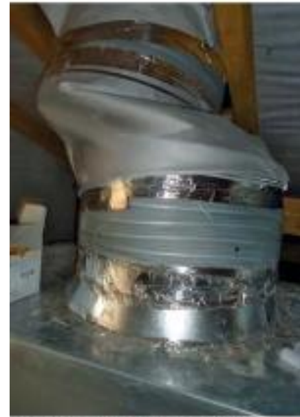
6. Diminution de la section du conduit.
