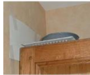
3. Sortie d'air supprimée pour l'installation de mobilier.
