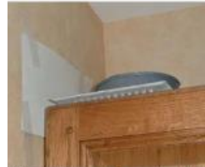
3. Sortie d'air supprimée pour l'installation de mobilier.
